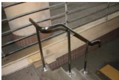
[手すりの設置]
